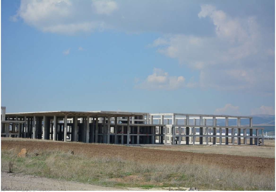
Şekil 5: Fuar ve Kongre Merkezi İnşaatı
