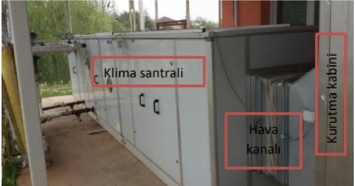
Şekil 2: Örnek Klima Santralinden Bir Görünüm
